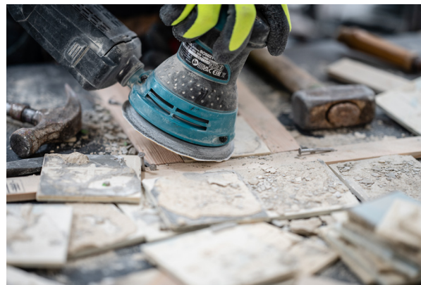
Les carreaux démontés sont nettoyés puis emballés pour un réemploi ultérieur.
