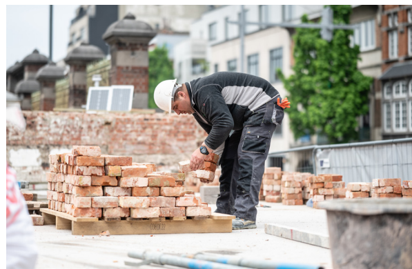
Démontage soigneux de briques pour leur réemploi sur site.
