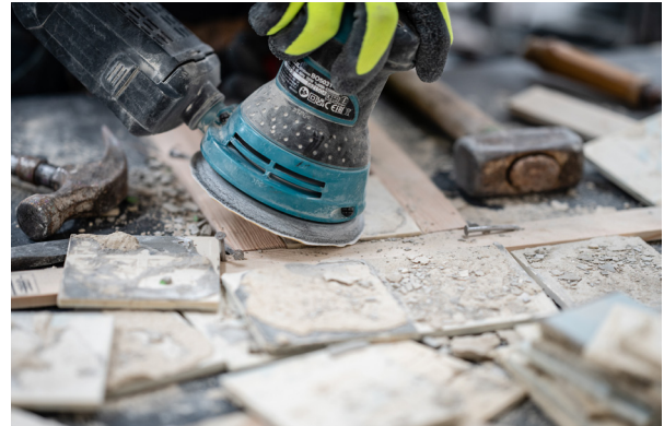
Gedemonteerde tegels worden schoongemaakt en verpakt voor later hergebruik
