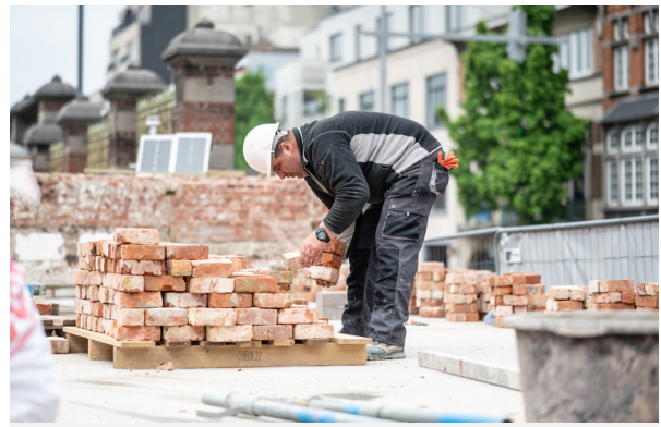
Voorzichtige ontmanteling van bakstenen voor hergebruik ter plaatse.
