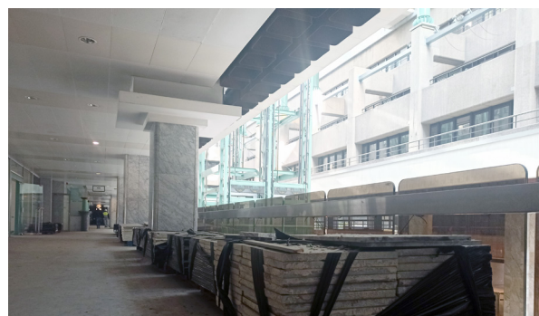
De grandes quantités de dalles en marbre ont été soigneusement démontées et emballées par des opérateurs du réemploi. © Buildwise
