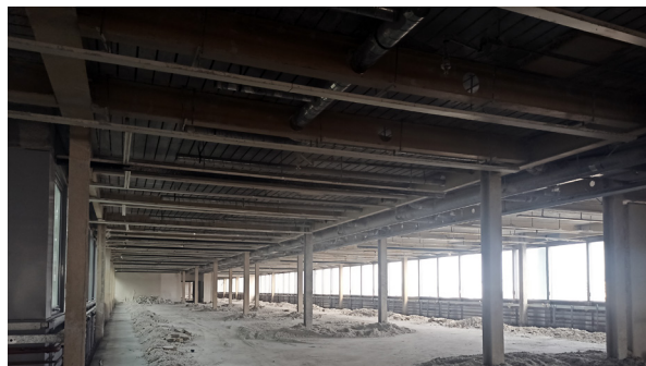
De metalen structuur, blootgelegd na het strippen van het gebouw. Na het zandstralen van de brandwerende coating zal ze door De Meuter afgebroken worden en naar een smelterij gebracht worden voor hoogwaardige recycling. © Buildwise
