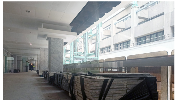
Grote hoeveelheden marmeren platen werden zorgvuldig ontmanteld en verpakt door hergebruikhandelaars. ©Buildwise
