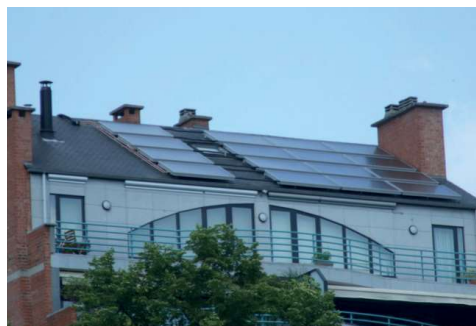
Mise en œuvre de 16 panneaux solaires thermiques Source : R. Nibus
