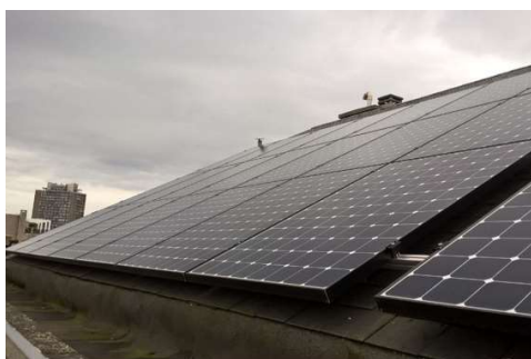
Mise en œuvre de 42 panneaux photovoltaïques (puissance crête = 13,4 kWc). Source : I. NIJSKENS
