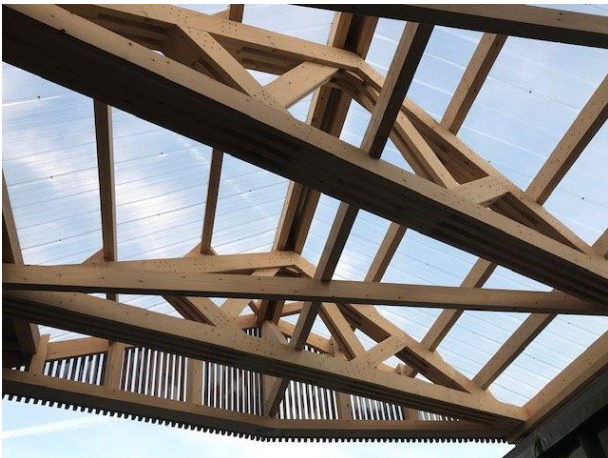
Abb. 15 - Dachkonstruktion aus Fichtendübeln in Épinal [U Lorraine].
