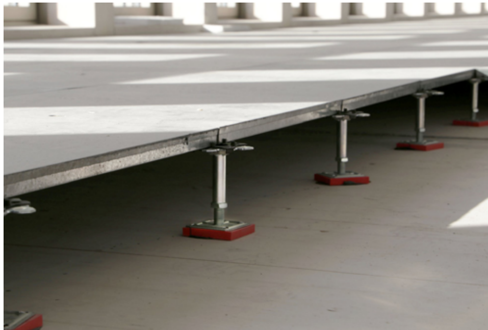
Herplaatsing van verhoogde vloerplaten voor hergebruik met nieuwe vijzels
