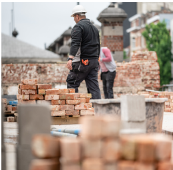
Dépose de briques - Caserne d'Ixelles © Ekkow Photography - Buildwise
