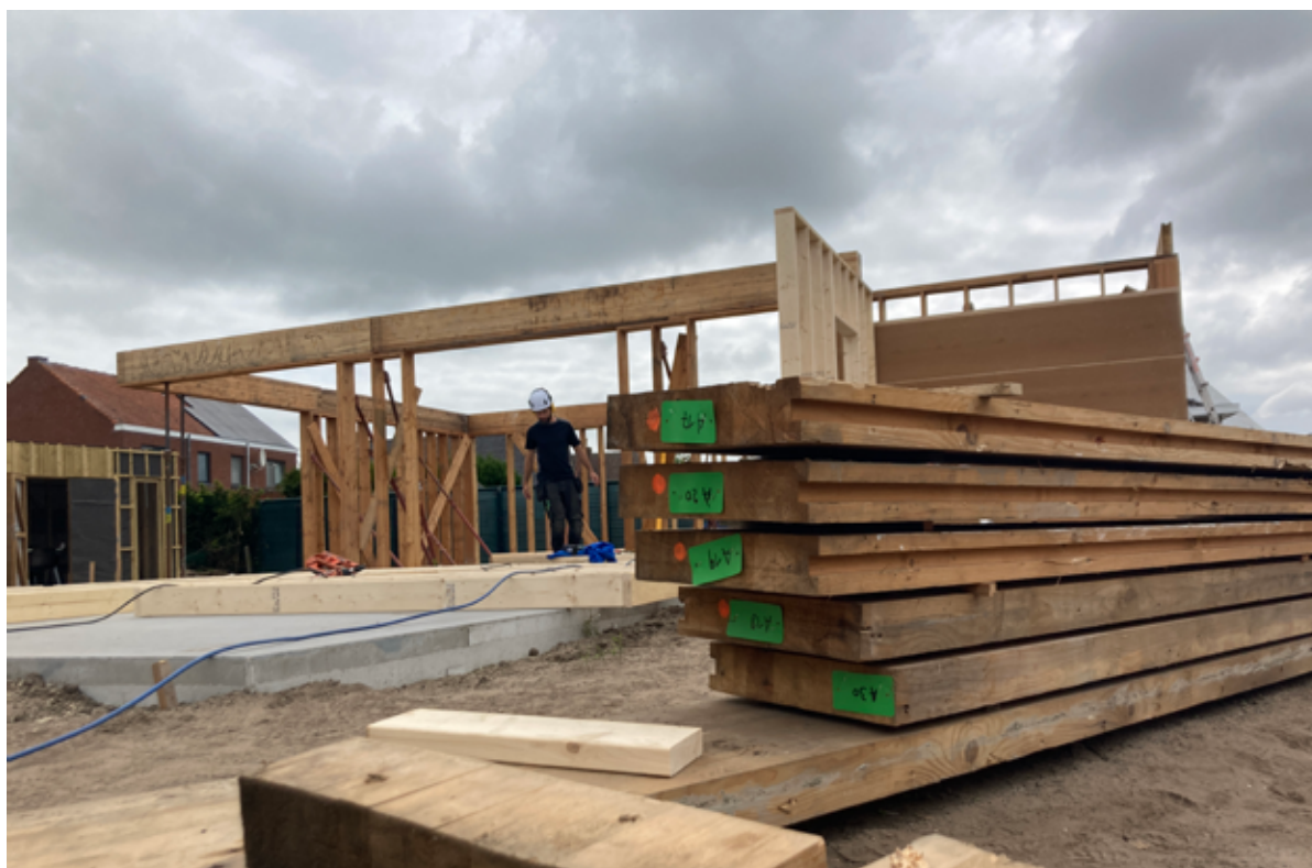
Exemple de marquage appliqué sur des poutres en bois lamellé collé © HuisMus - Trovo
