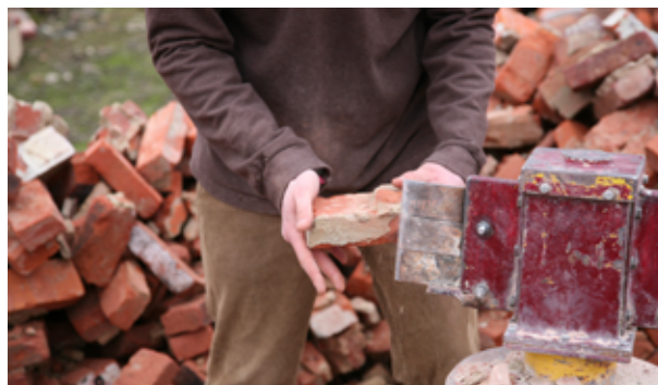
Nettoyage manuel et mécanique des restes de mortier © Opalis
